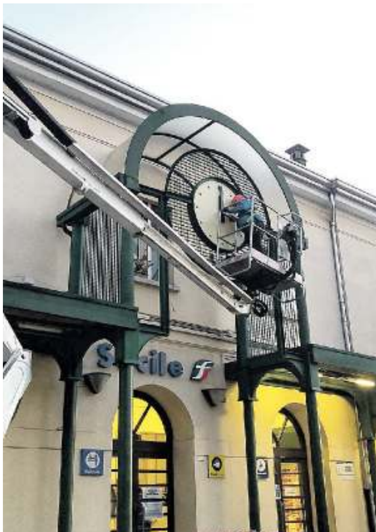
RIPARAZIONE Il ripristino dell'orologio della stazione ferroviaria
